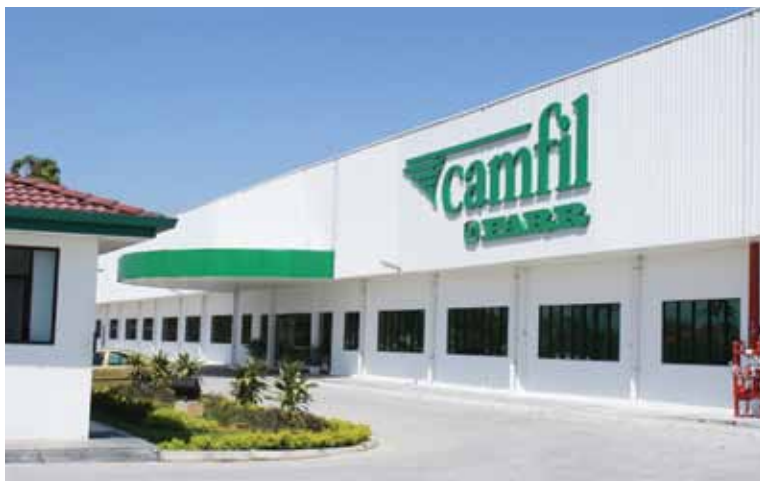
Camfil Farr - マレーシアのイポー工場
